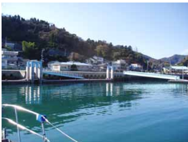
寄り道偵察した下蒲刈港の災害時避難用棧橋
